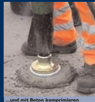
...und mit Beton komprimieren
