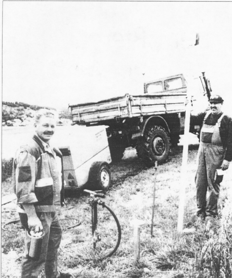
Geislingens Bauhofleiter Franz Ott (links) und sein Mitarbeiter Jürgen Bühler setzen beim Schilder-Anbringen auf ein schwäbisches Patent, den Wurzelpfahl. In zehn Minuten steht das Radschilder beim Wanderparkplatz in Erlaheim. Die neue Methode rechnet sich nicht nur in Mark und Pfennig, sondern schont auch die Umwelt. FOTO: ROSALINDE RIEDE
