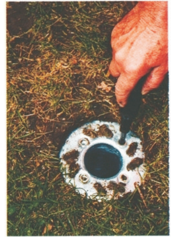
den Naturboden bis zur Gesamtlänge eingeschlagen, sodass die Oberfläche circa 3 bis 5 Zentimeter unter Terrainniveau liegt.
