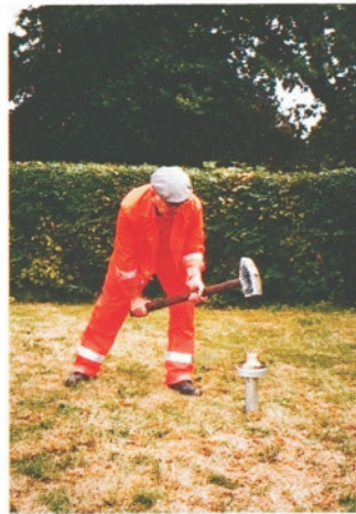
Zur Schilder- und Pfostenmontage im Naturboden wird der „Wurzelpfahl Ferradix“ beispielsweise mit aufgesetztem Einschlagwerkzeug in
