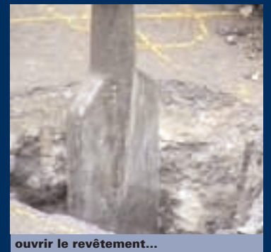
ouvrir le revêtement...
